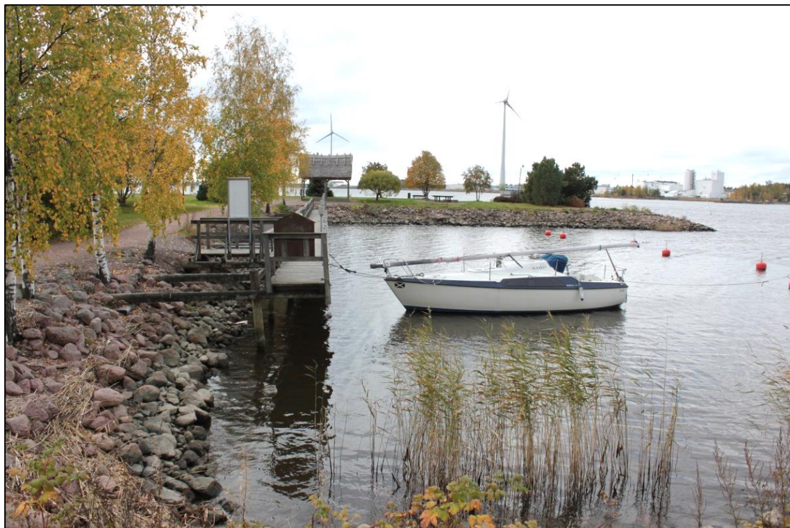
Kuva 2. Rampsinkarin nykyinen vieraslaituri etelän suuntaan kuvattuna (FCG Suunnittelu ja tekniikka Oy, pvm. 4.10.2016)
