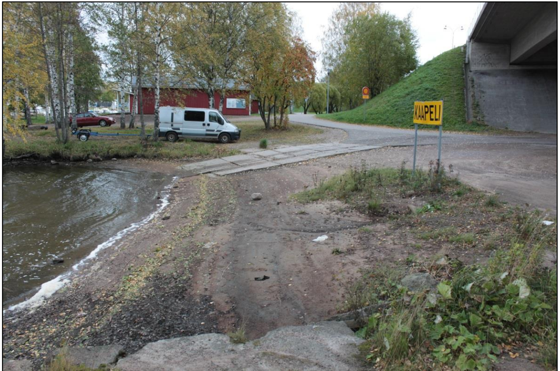
Kuva 8. Rantaluiskaa ja veneluiska. Oikealla ylhäällä nähtävissä silta (FCG Suunnittelu ja tekniikka Oy, pvm. 4.10.2016).
