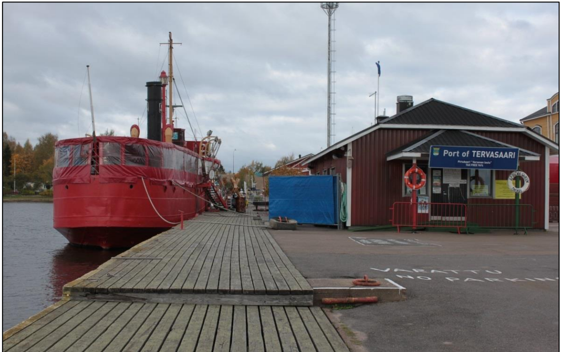
Kuva 6. Nykyistä puukantista puupaalulaituria pohjoisen suuntaan kuvattuna. Laiturissa ravintolana toimiva majakkalaiva s/s Hyöky (FCG Suunnittelu ja tekniikka Oy, pvm. 4.10.2016).
