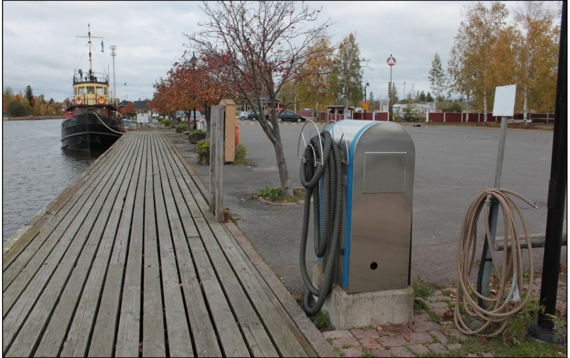
Kuva 5. Nykyistä puukantista puupaalulaituria pohjoisen suuntaan kuvattuna. Etualalla vesiletku, septitankin imutyhjennyspiste sekä pelastusrenkas (FCG Suunnittelu ja tekniikka Oy, pvm. 4.10.2016).
