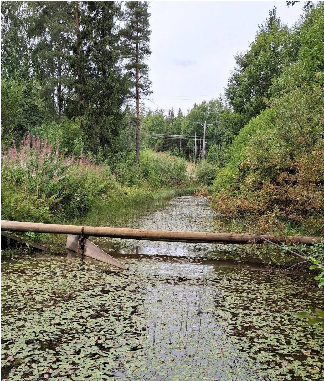
Kuva 8. Ojaan tehty allas, joka hidastaa laskuojan virtausta.
