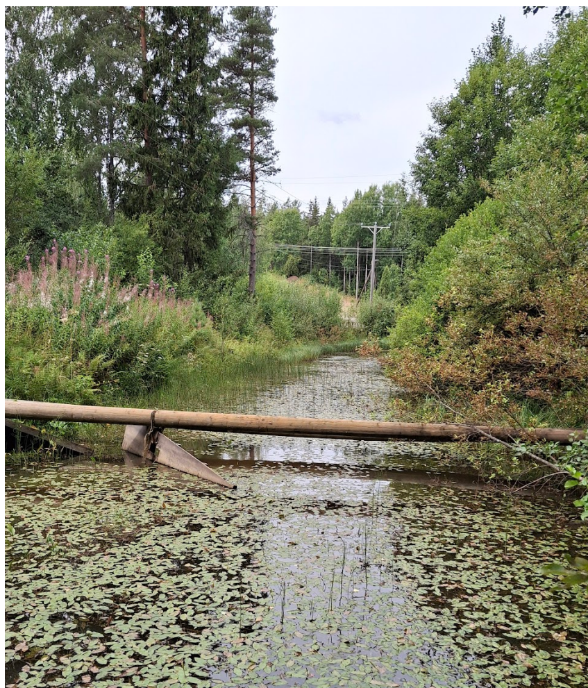
Kuva 8. Ojaan tehty allas, joka hidastaa laskuojan virtausta.
