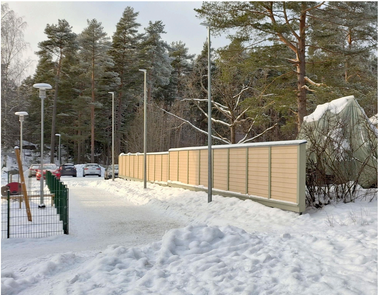
Kuva 8: Uuden koulun ja päiväkodin rakentamisen yhteydessä alueen pohjoisosan läpi on rakennettu yleinen jalankulku- ja pyöräily-yhteys Tenkkiilintieltä Siitosentielle.
