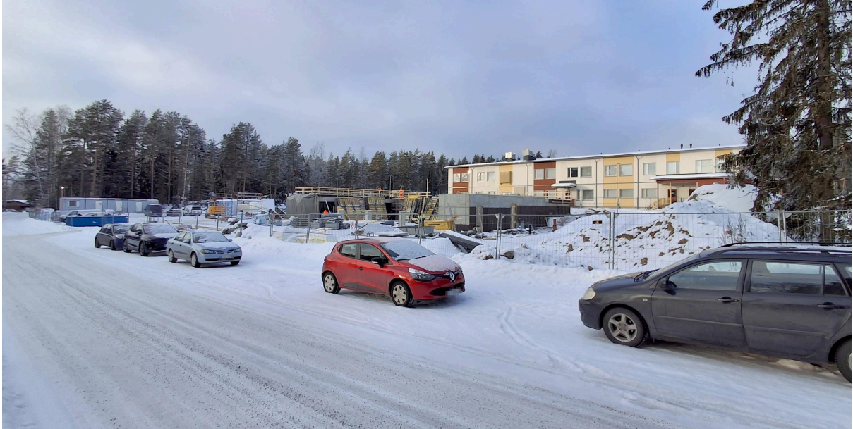
Kuva 2. Näkymä Pähkinätieltä. Edustalla rakenteilla oleva liikuntahalli. Takana jo valmistunut koulurakennus.
